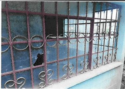
Foto 5: Sustitución de vidrios
