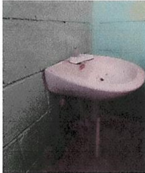
Foto1: Sustitución de lavamanos
