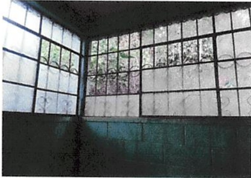
Foto 1: Sustitución de vidrios
