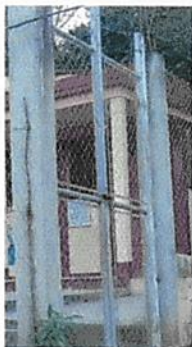
Foto 5: Sustitución de portón
