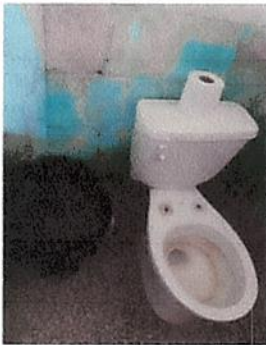
Foto 3: Instalación de baño
