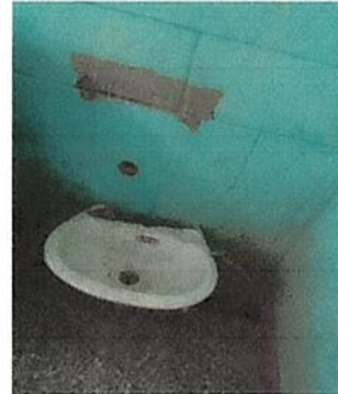
Foto 2: Sustitución de lavamanos
