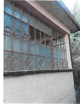
Foto 4: Instalación de vidrios
