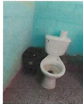
Foto 4: Instalación de baño
