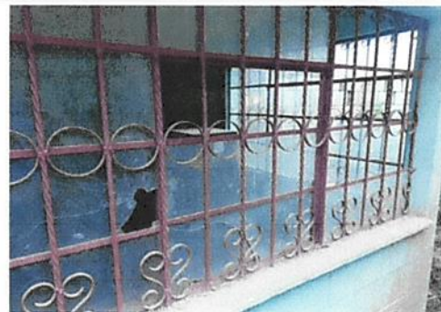
Foto 6: sustitución de vidrios
