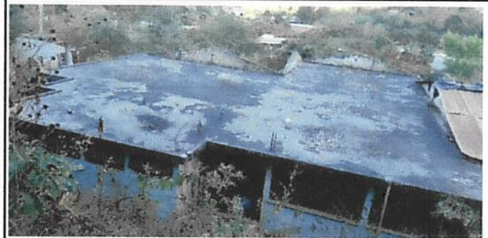
Foto 6: Cimiento de terraza con desnivel para drenajes
