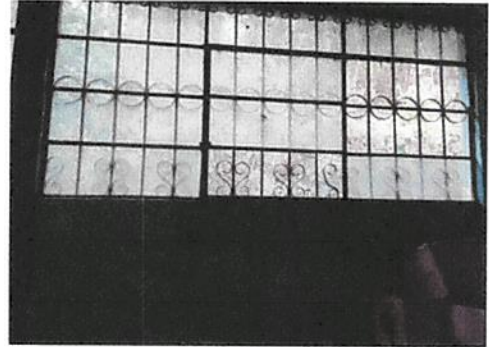
Foto 2: Sustitución de vidrios
