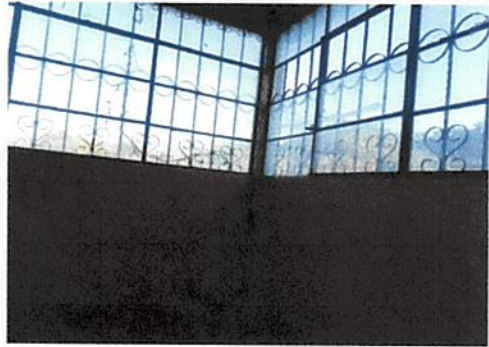
Foto 3: Instalación de vidrios
